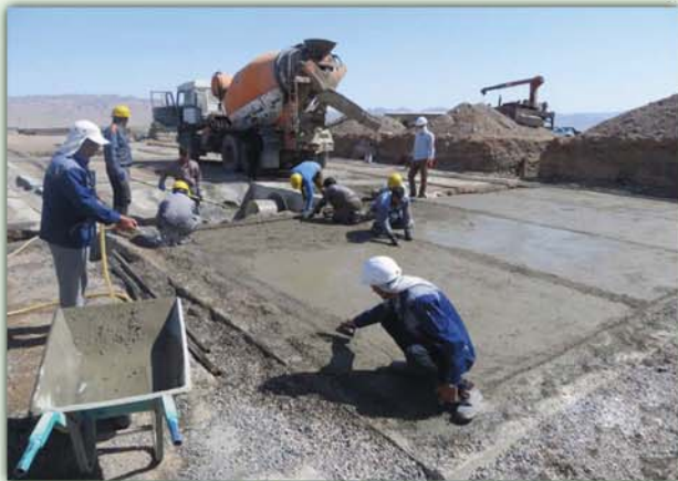
اجرای بتن مگر کف مخزن ۲۰۰۰ متر مکعبی
